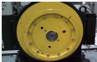
图 43 拆除曳引轮螺栓
